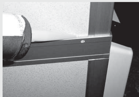
Nach abgeschlossener Kabinenmontage Oberteil und Unterteil umlaufend mit Silikon abdichten Après l'assemblage de la cabine, étanchéfier avec du silicone entre le haut et le socle. After installation of cubicle the upper and bottom part are sealed with silicone
