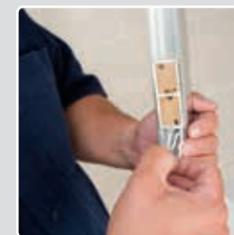
**1** Fläche von Schmutz und Fett befreien und Schutzfolie des Adapters entfernen.
