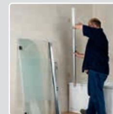
**2** Profil mit Adapter an die Wand drücken, sodass der Adapter an dieser fixiert wird.
