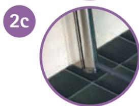
Alternativ wird die Duschkabine einfach auf den Boden gesetzt, ohne auf eine Fuge zu achten.
