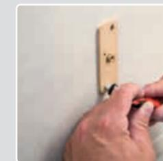
**3** Öffnungen mit Kleber befüllen, bis der Kleber an den Kontrollöffnungen austritt.
