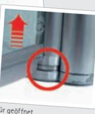
Der verdeckte Heb-Senk-Mechanismus in unseren Profilen hebt die Duschtür beim Öffnen leicht an und senkt sie beim Schließen wieder ab. Dies garantiert eine erhöhte Dichtigkeit und ein zuverlässiges Schließverhalten.
