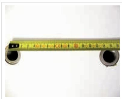
**1** Zunächst Maß kontrollieren. Mit Hanf oder Dichtband vor dem Einschrauben abdichten! Dann Dichtung und Blenden aufstecken sowie das Thermostat befestigen.
