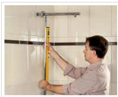
**2** Die Kopfbrause sollte in Körpergröße plus 150 mm hängen. Das Gestänge entsprechend der Armaturhöhe ausziehen (mindestens 20 mm). Mittels Wasserwaage ausrichten, dann fixieren und markieren.
