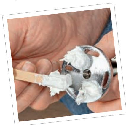
**3b** ... Kleber aus unserem Set „Einfach Kleben System“ anrühren und Montageplatte ankleben. Nach ca. 5 Stunden kann das Gestänge aufgesteckt und mittels Gewindestift befestigt werden. Waagerechte Stange befestigen und Kopfbrause und Handbrause anschrauben. **FERTIG!**
