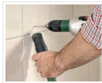
**3a** Markierte Stellen bohren und Montageplatte für waagerechte Stange anschrauben. Oder ...
