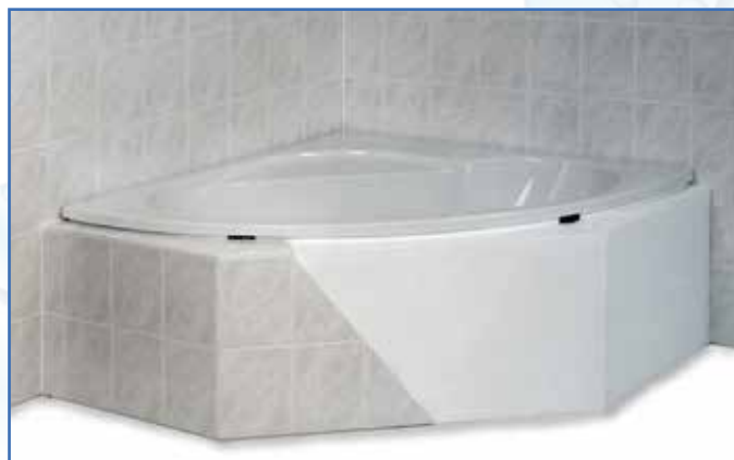
Eckwannenträger kurz vor Abschluß der Verfliesung
